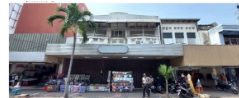
Bangunan Jalan Pasar Baru No. 8 (Jean Machine Factory Outlet)
